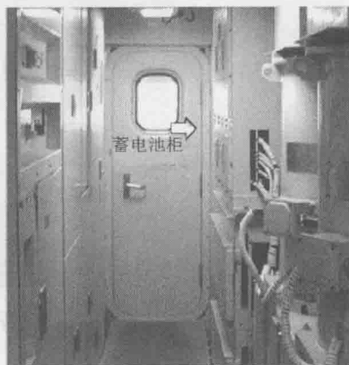
图 1.29 蓄电池滤波柜、电器控制柜的布置
