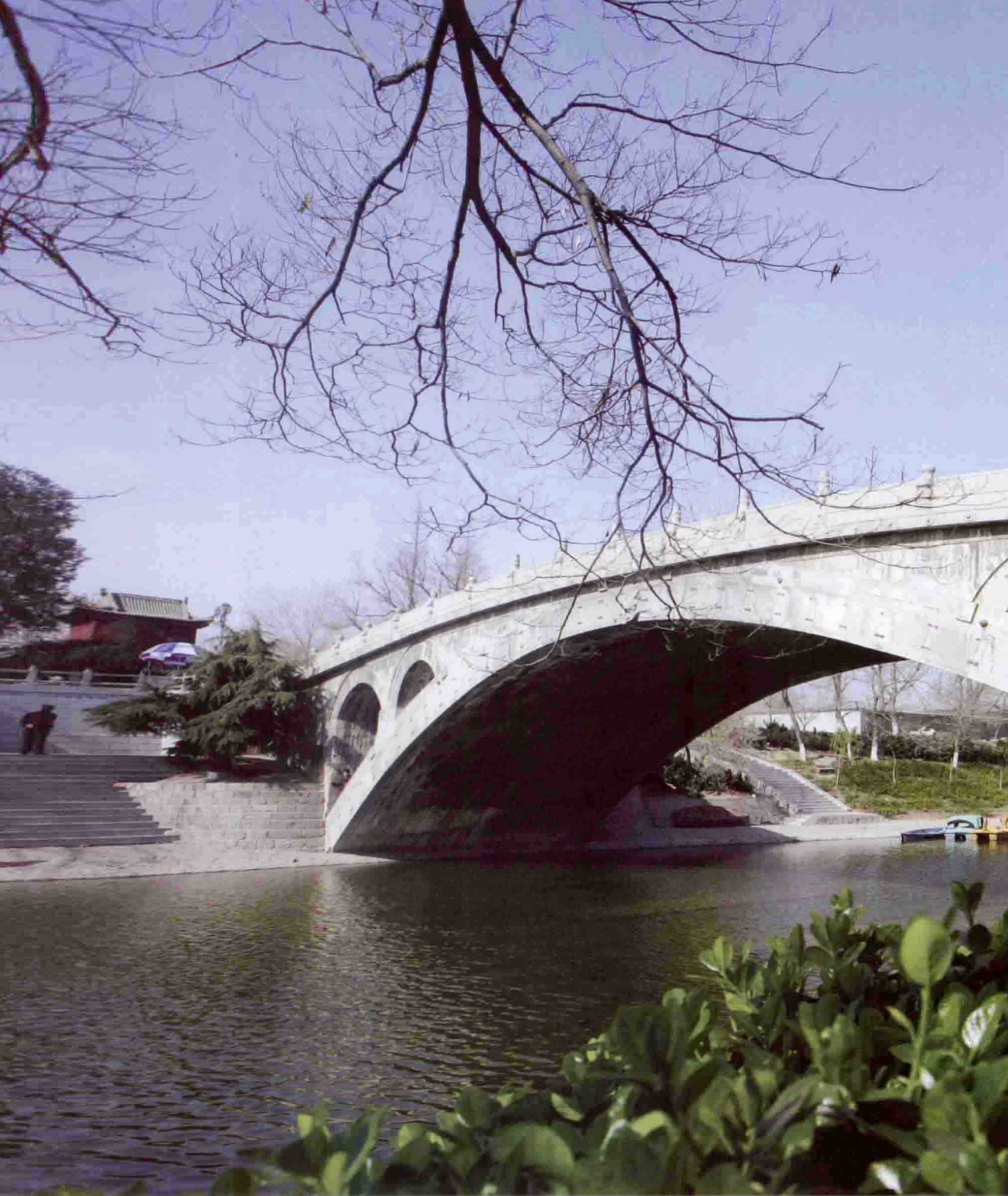
赵县洺河上的隋代李春主持创建的安济桥，又名赵州桥
