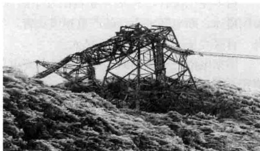
图 1-2 杆塔倒塌图
