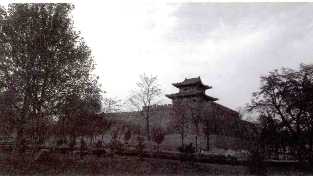
邢台古城墙一角
