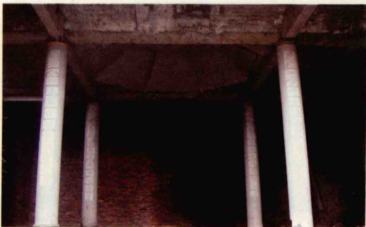
↑ 福建省宁德福安市南岸廉首房“高氏宗祠”正在建设中图片
