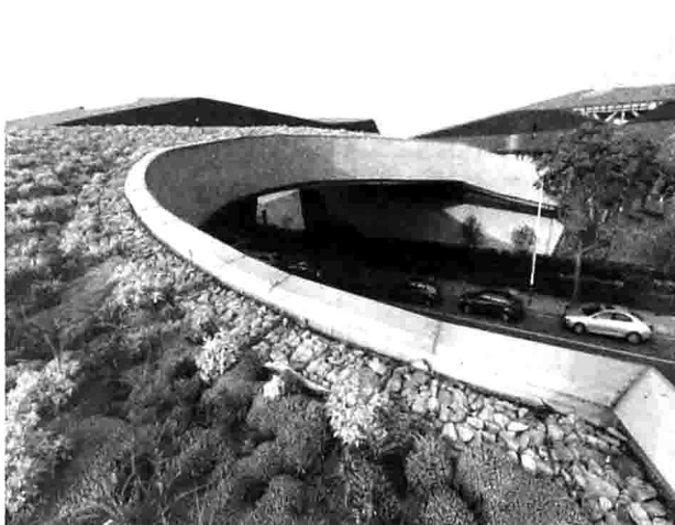
图 2-6 半精细式屋顶绿化：上海 巨人网络办公楼的屋顶花园
