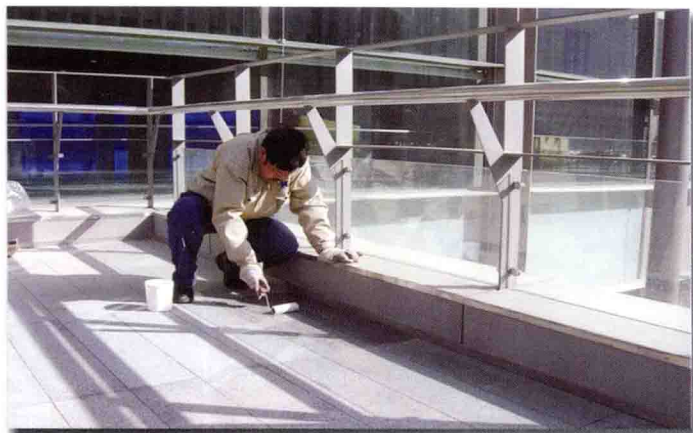
首创纳米科技公司的纳米防护液 用于奥运工程的钢结构
