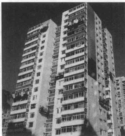
图 1.4 宅楼节能改造中的临街立面
