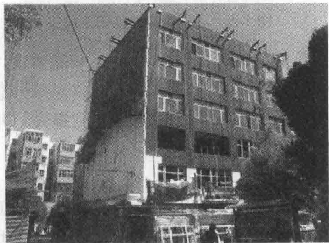
图 1.2 改造施工粘贴聚苯板
