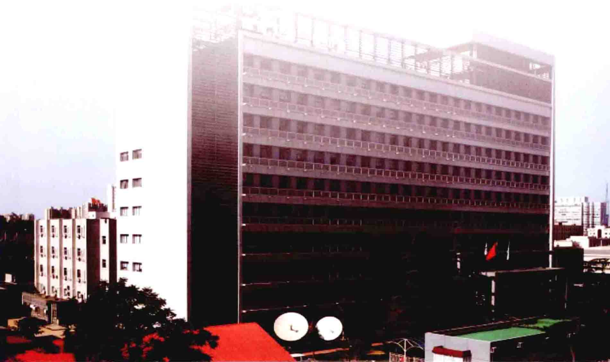
图 1.3 国家卫星气象中心大楼
