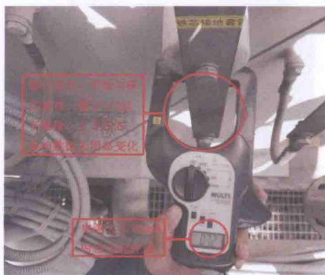
图 11 铁芯接地电流测试
