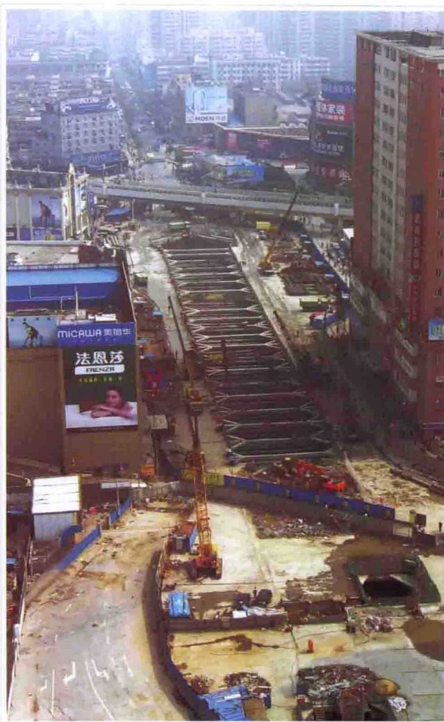
宜山路站基坑布置及周边环境鸟瞰图(Z3、Z4区施工)
