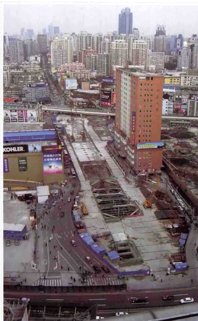
宜山路站基坑布置及周边环境鸟瞰图(Z1、Z2区施工)
