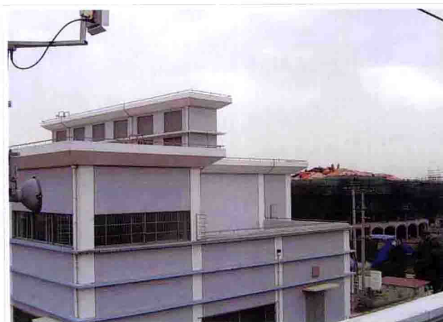
佘山主变电所
