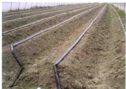
彩图 20 铺设渗管
