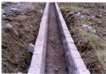
彩图 25 供水斗渠
