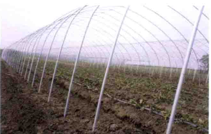
彩图 48 钢筋骨架连栋大 (蚌埠海上明珠生态园)
