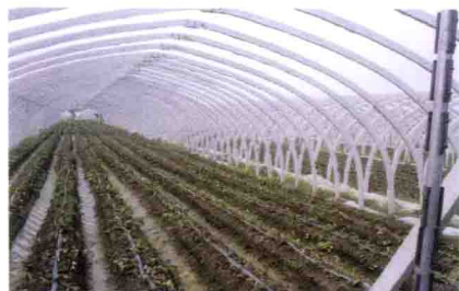
彩图 47 苦土结构连栋大 (蚌埠海上明珠生态园)
