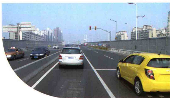
匝道与主线交替控制信号灯 ▲
