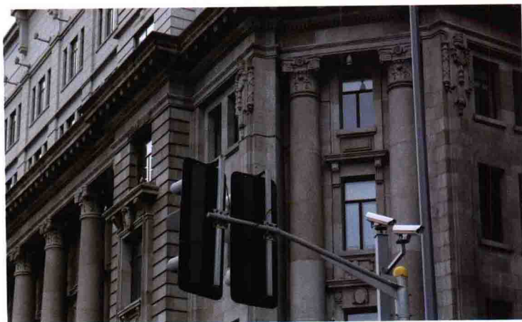
▲ 道路交通监控
