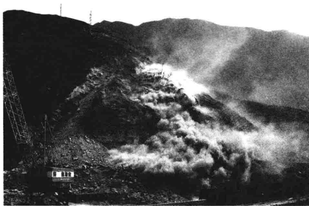
图 1-6 圆弧形破坏
