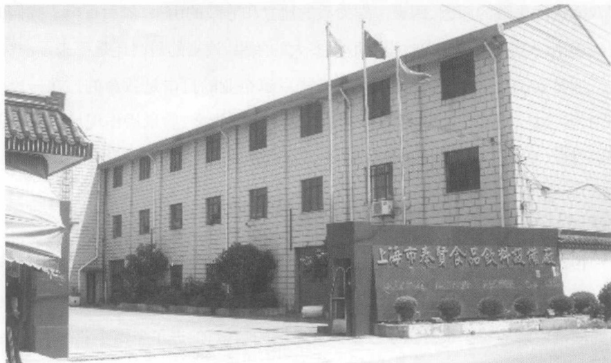
原胡桥机修厂厂房,现为奉贤食品饮料设备厂
