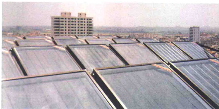
可供 500~600 人使用的大面积太阳能热水器
