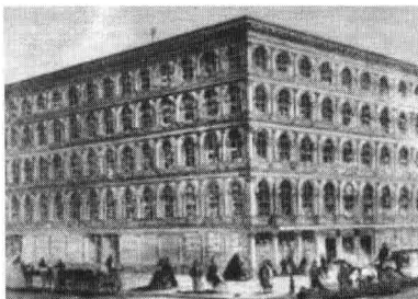
图 1-5 安装奥的斯公司第一台客运升降机的纽约 E. V. Haughwout 公司的一座商店
