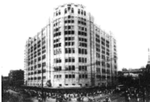
图 1-17 大新公司——我国最早安装自动扶梯的建筑
