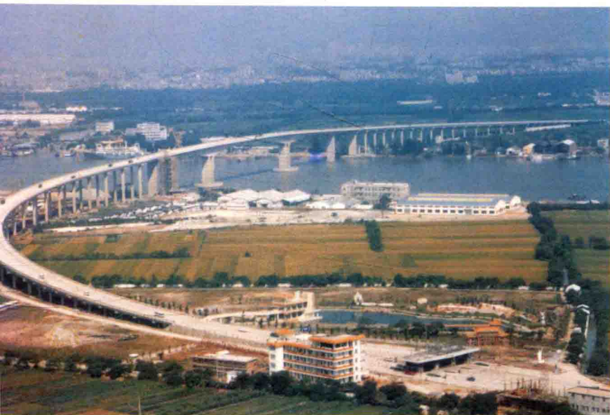
全省最高（净空34米，全长1916米）主要由县自筹资金建成的番禺洛溪大桥（何洪伟摄）
