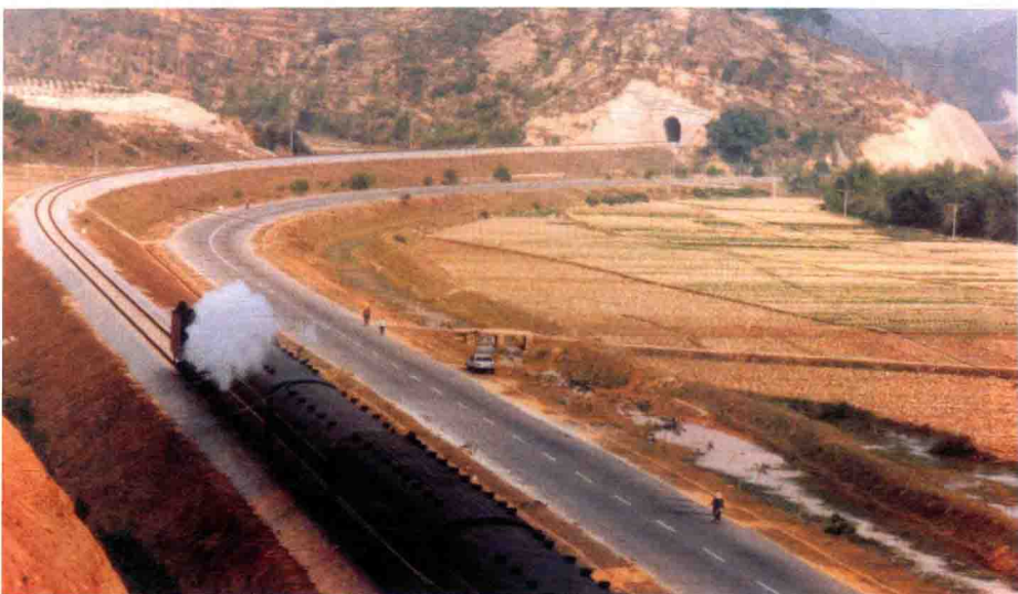
最先由地方集资建设和经营的铁路——三（水）茂（名）铁路（梁伯权摄）
