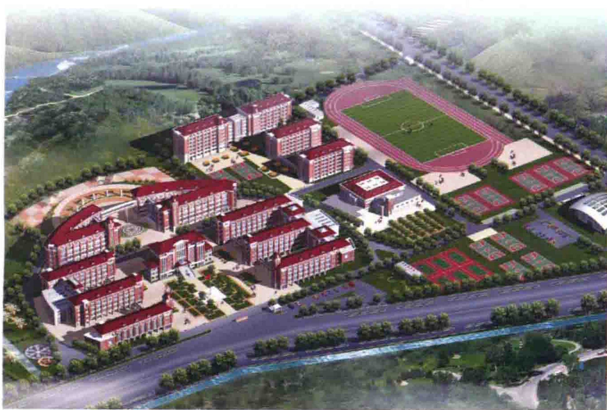
山东兴华建设集团承建的区致远中学工程
