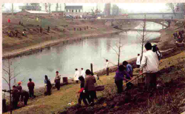
▲ 混凝土护坡前，组织民工在医务人员指导下处理岸坡表层土，防止钉螺扩散。
