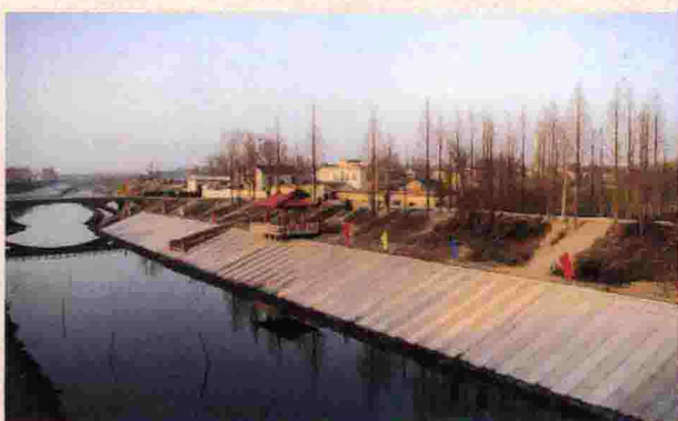
▲ 便民河水系之一，七乡河混凝土护坡现场。
