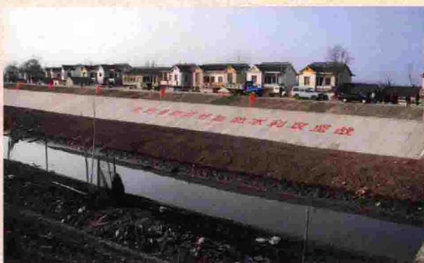
▲ 便民河下蜀镇段施工现场（河床内的废弃土待清除）
