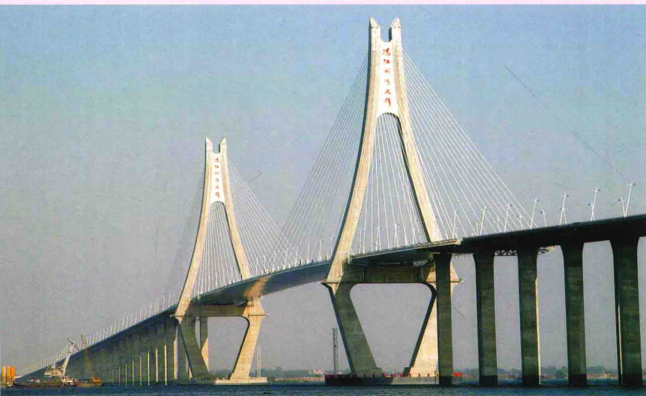
湛江海湾大桥
