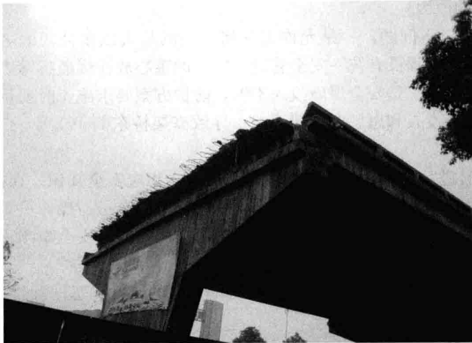
图 2-1 湖南省株洲市“5·17”桥梁拆除工程坍塌事故现场（一）
