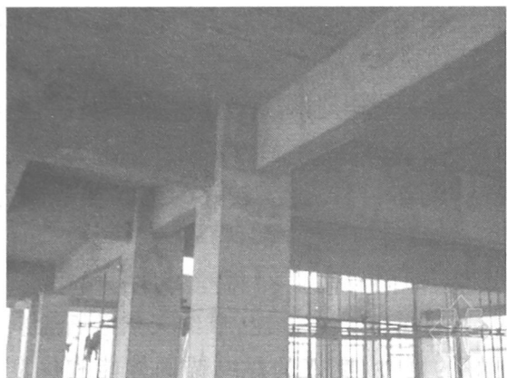
图 0-1 现浇混凝土楼盖
