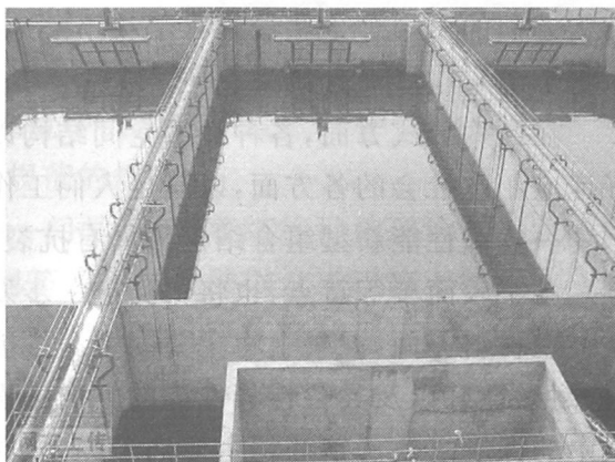
图 0-2 现浇混凝土水池
