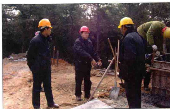
2010年12月4日，公司副经理潘永忠到220千伏桃平双回线路重冰区改造工程现场调研
