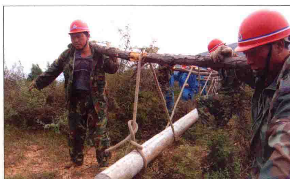
2006年9月13日，“户户通电”工程建设现场
