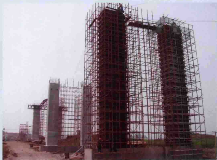
建设中的郧县汉江二桥
