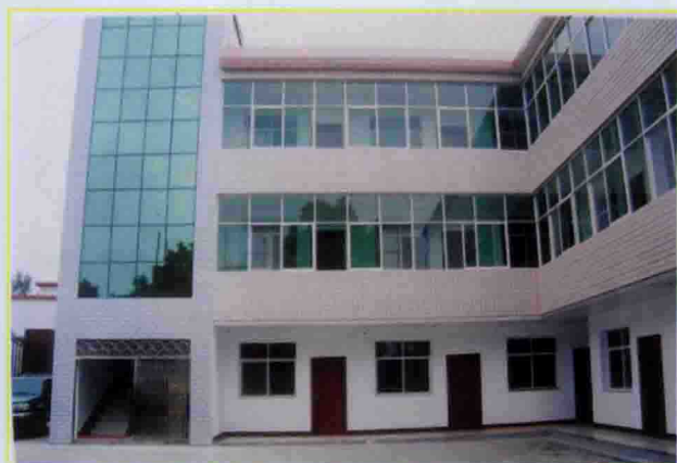
基层移民站办公楼
