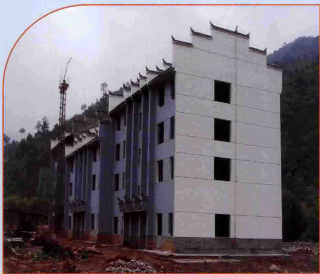
建设中的叶大乡新集镇移民居民点
