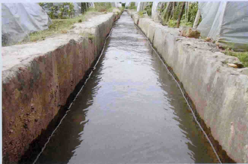
库区引水渠道
