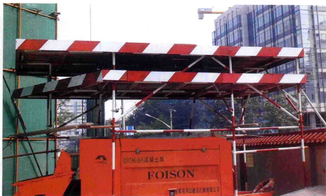
混凝土泵防护
