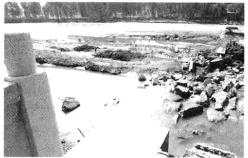
d) 洛阳栾川县潭头镇汤营村某桥
