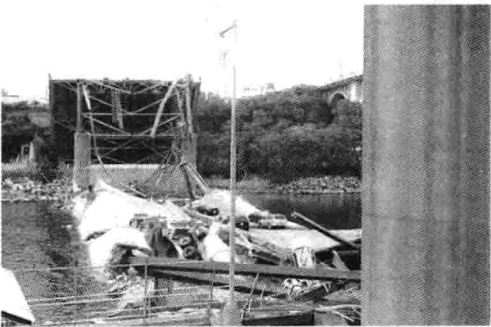
a) I-35W 大桥崩塌
