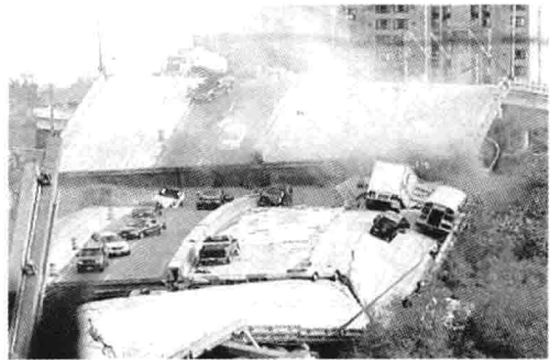
b) 美国明尼苏达州一座桥梁坍塌
