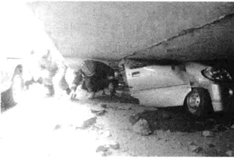
c) 湖南株洲市红旗路高架桥
