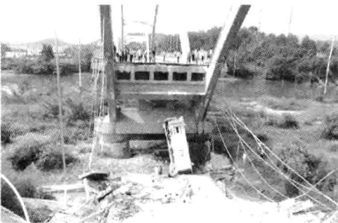
g) 武夷山公馆斜拉桥
