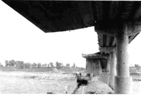
a) 辽宁省营口市熊岳大桥
