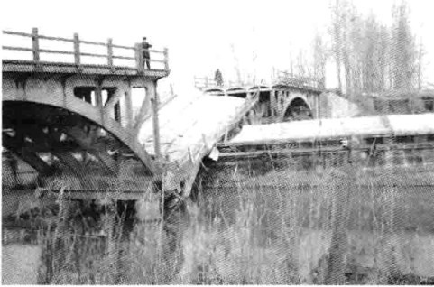
e) 江苏盐城秦南镇跨河大桥
