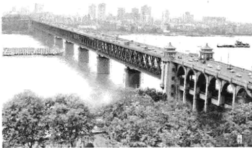
a) 武汉长江大桥
