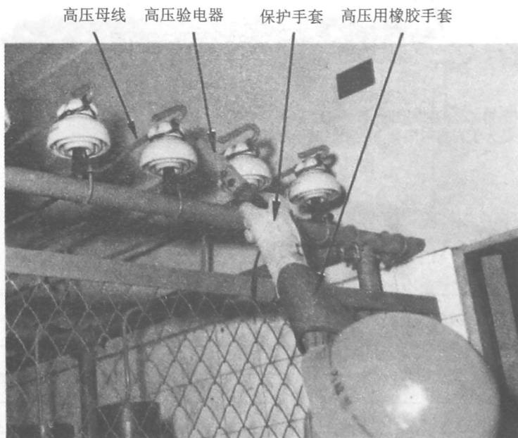
图 1.7 6kV 高压验电作业
