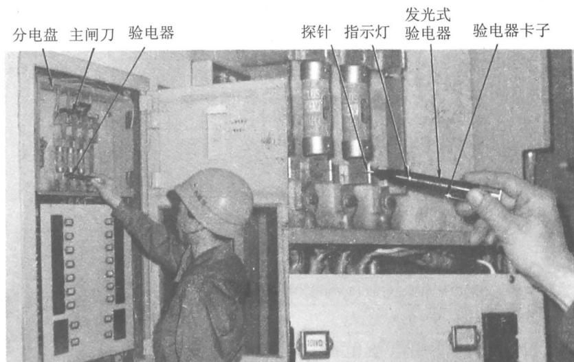
图 1.3 氖管发光式验电器验电
