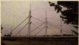
辽宁·沈阳 蒲河大桥
