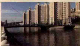
辽宁·大连 马栏河星海大桥
