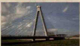
内蒙古·霍林郭勒 二号桥
