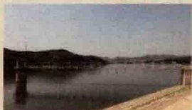
辽宁·大连 牧城塘水库桥
