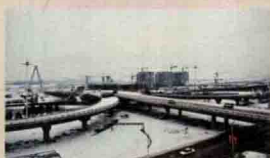
内蒙古·霍林郭勒 珠斯花大街立交桥
