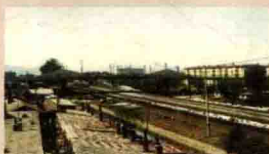
辽宁·普兰店 立交桥
