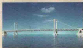
辽宁·大连 星海湾跨海大桥
