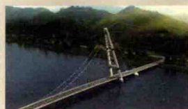
辽宁·朝阳 燕阳山南路大桥
