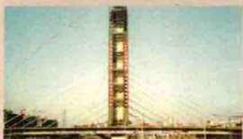
辽宁·沈阳 公和斜拉桥
