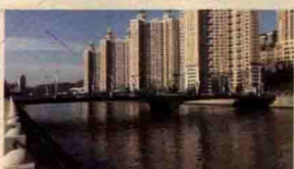
辽宁·大连 马栏河星海大桥
