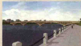
辽宁·庄河 小寺河系杆拱桥
