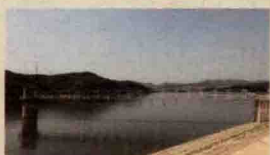
辽宁·大连 牧城塘水库桥
