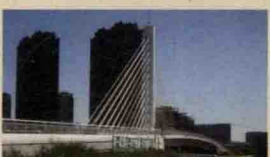
辽宁·东港 人民路桥
