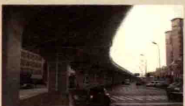
辽宁·大连 东北路立交桥加宽 改造工程
