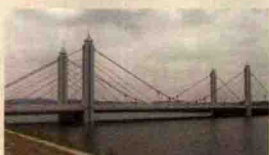
辽宁·庄河 建设大街西桥
