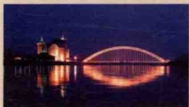
辽宁·丹东 月亮岛大桥
