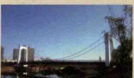
辽宁·东港 太平湖人行桥
