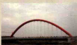
辽宁·营口 经济技术开发区滨 湖路单肋拱桥
