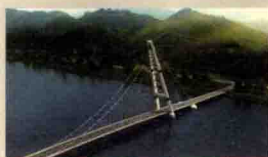
辽宁·朝阳 燕阳山南路大桥
