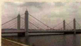
辽宁·庄河 建设大街西桥
