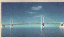
辽宁·大连 星海湾跨海大桥
