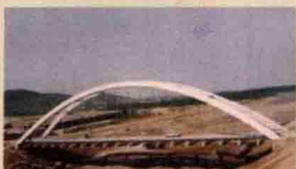
辽宁·瓦房店 东风水库桥
