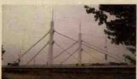
辽宁·沈阳 蒲河大桥
