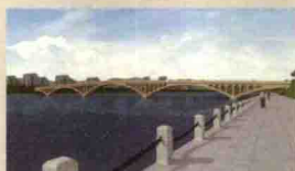
辽宁·庄河 小寺河系杆拱桥
