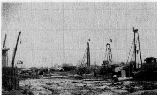
图 1-5 淮北临涣电厂 (2×300MW)
