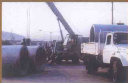
1997年，荆门市市政公司桥涵施工现场
