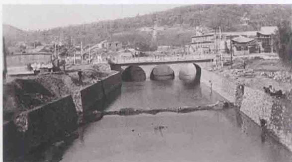
1986年,修建的竹皮河三眼桥段挡土墙
