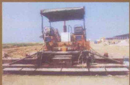
2007年6月，荆门市市政现代沥 青混凝土摊铺机施工现场
