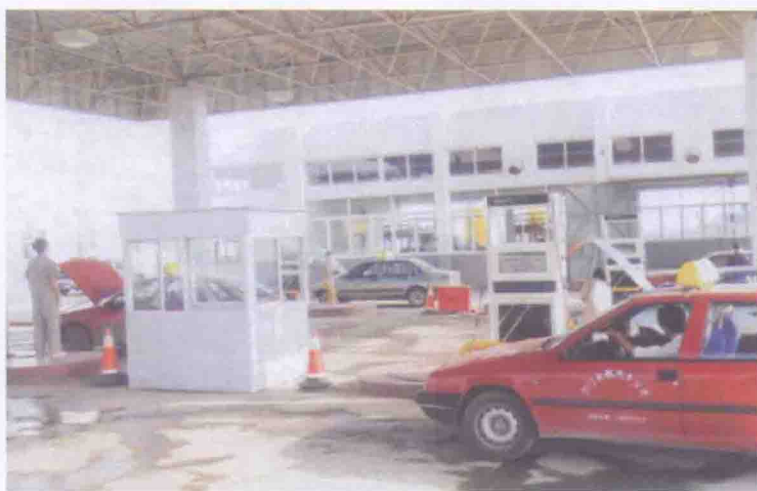
2007年6月的中石油昆仑燃气公司输配气设施
