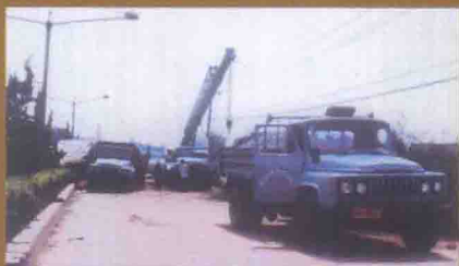
1996年8月，市市政公司机械作业现场
