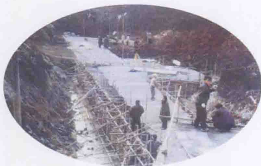
2001年12月 20日，市市政公司 龙井桥施工现场
