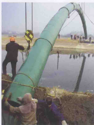
1999年3月，安装三水厂跨越总干渠长63米口径1 000毫米双管拱型备用水源管道
