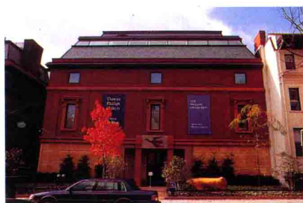
由日本鄉夫婦捐贈擴建的新館「鄉分館」。
