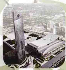
锦州国际酒店加固工程
