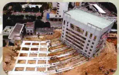
国家博物馆加固工程
