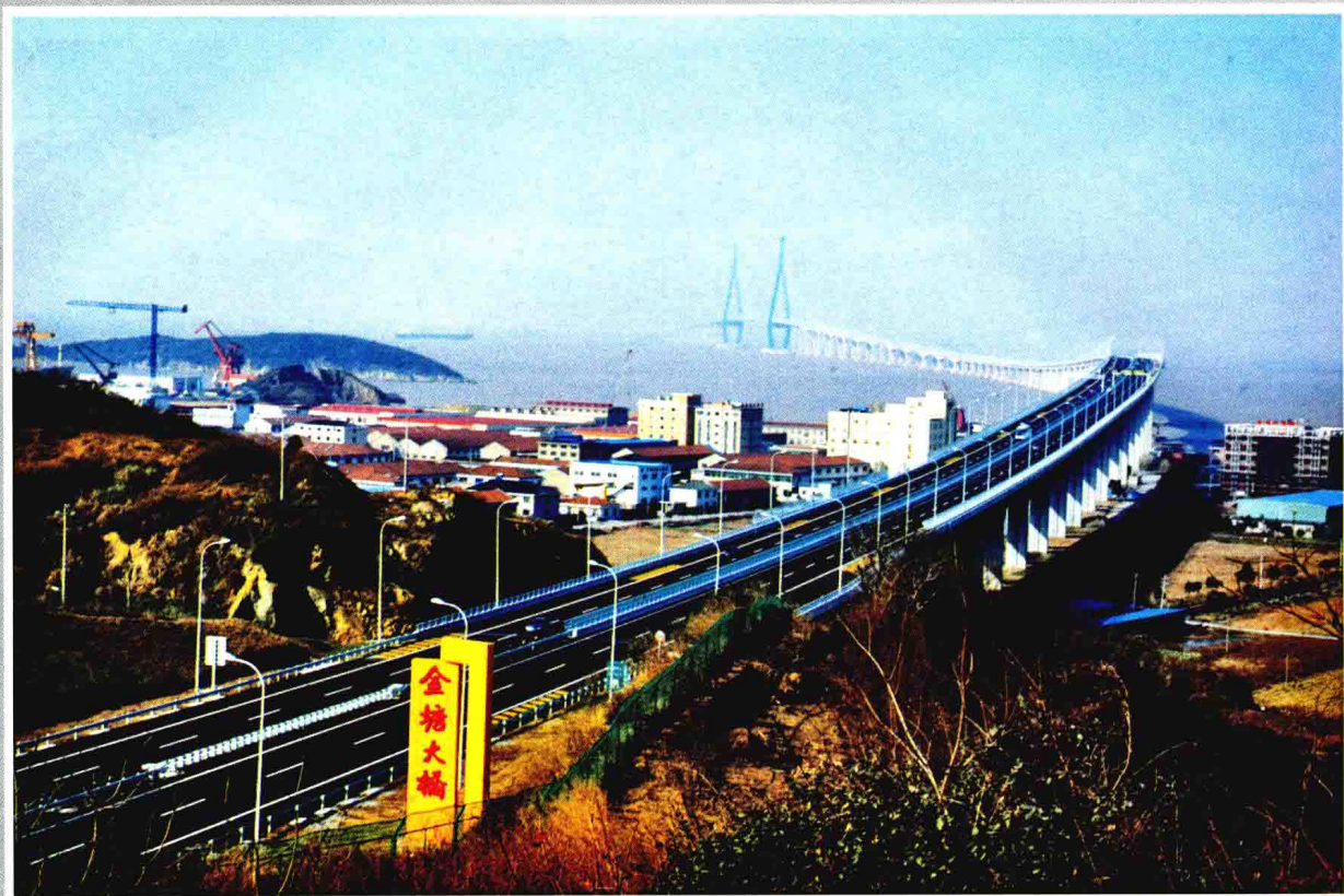
舟山大陆连岛工程——金塘大桥
