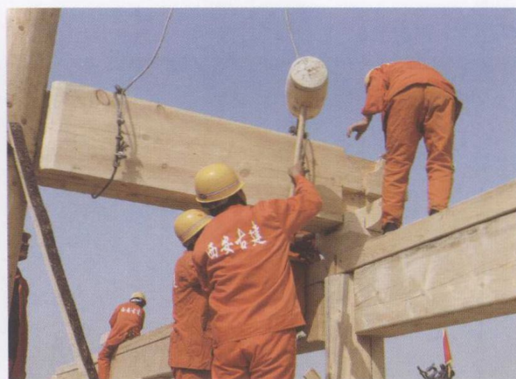
4-6 永宁门复建工程——下檐 大木结构安装
