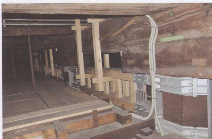
4-3 日本招提寺内部大梁加固
