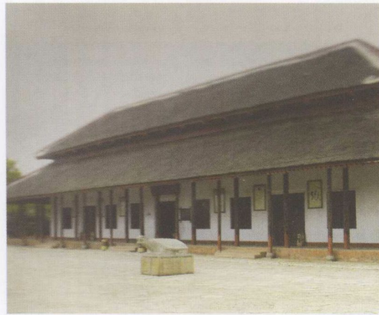
1-6 在殷商都城遗址上根据柱础和 史料复原的商代宫殿
