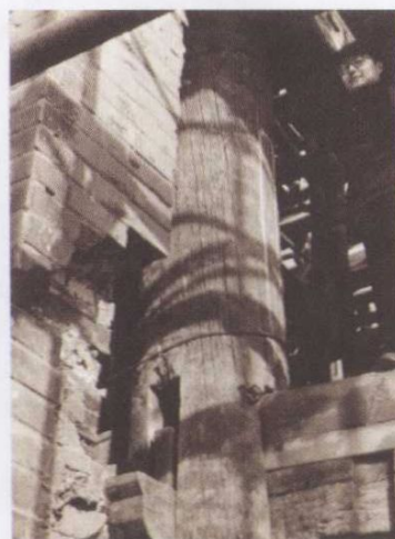
4-4 东门箭楼维修
