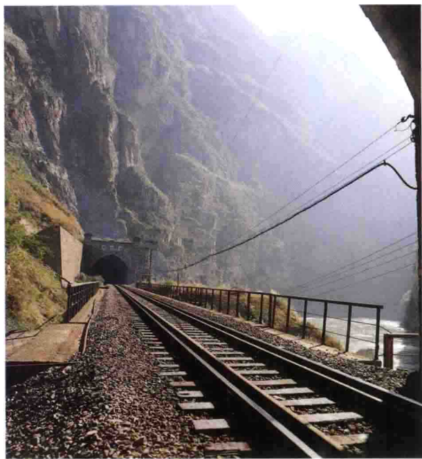
成昆铁路关村坝隧道
