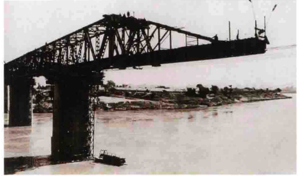
黎湛铁路贵县郁江大桥施工
