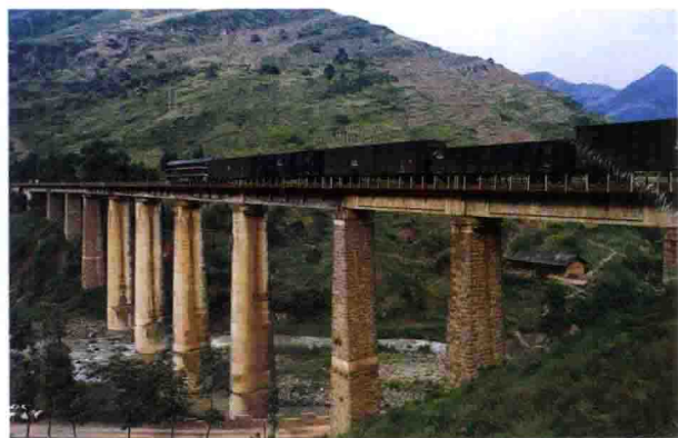
川黔铁路蒙渡大桥
