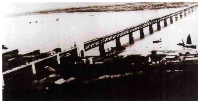
浙贛铁路钱塘江大桥（1937年）
