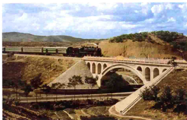
韶山铁路钢筋混凝土双曲拱桥
