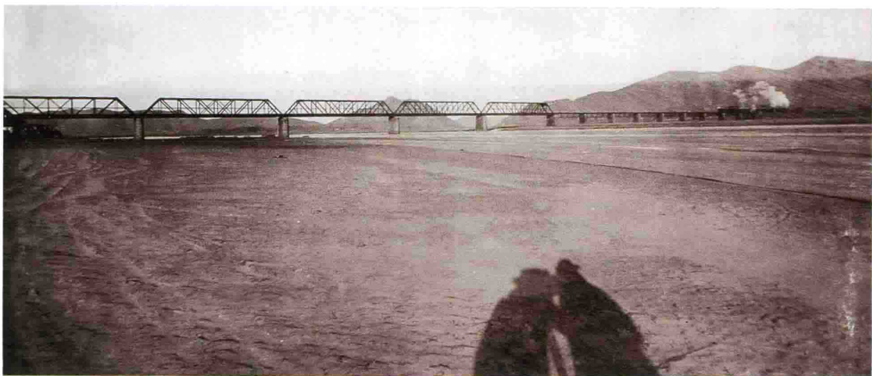
中国最早采用气压沉箱基础的滦河大桥（1889年）
