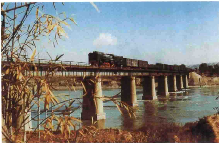
新中国黄河第一桥——兰新铁路河口镇黄河大桥 (1955年)
