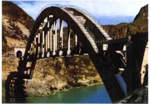
丰沙铁路永定河七号桥
