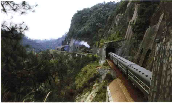
鹰厦铁路路基边坡防护工程
