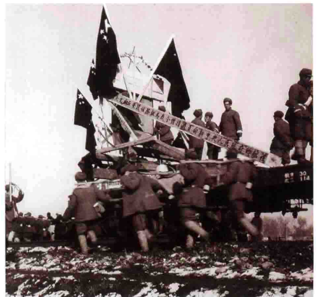
抢建津浦铁路蚌埠淮河大桥
