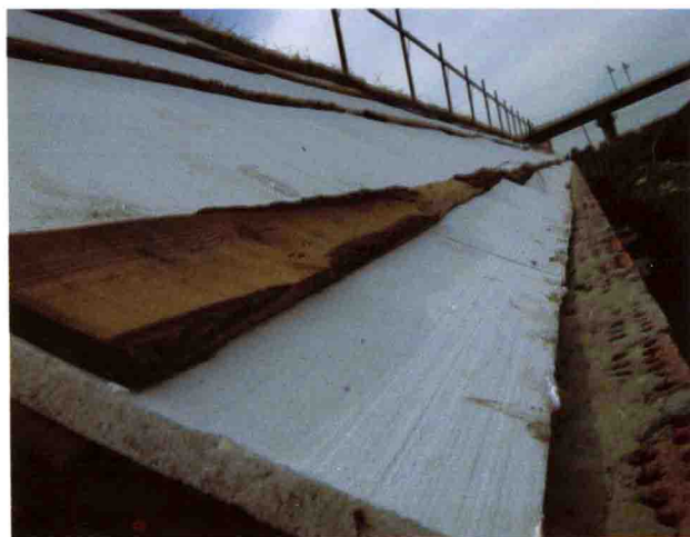
温室后坡装苯板提高保温性
