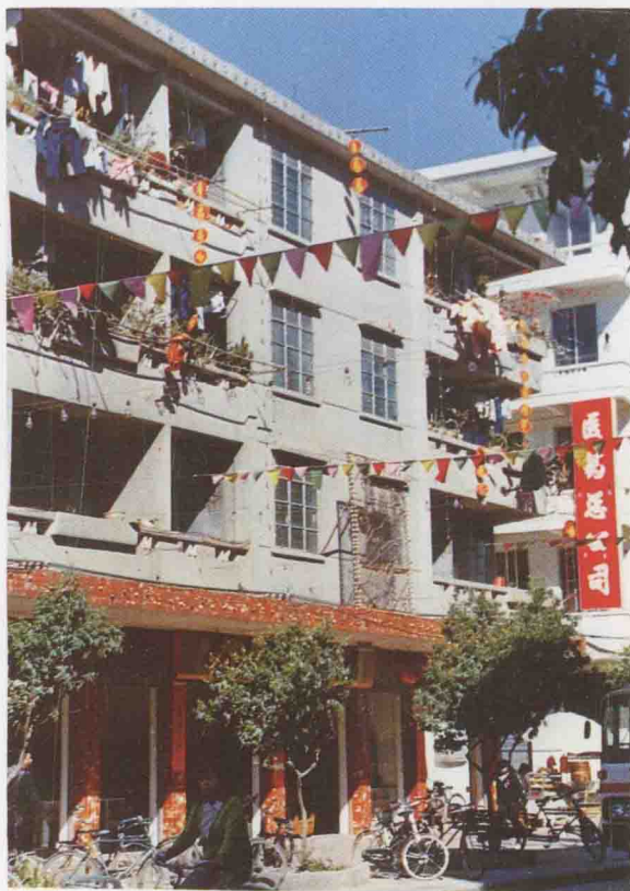
上图是位于恩新东路21号的医药 总公司，底层华昌贸易行，1985年建 成。
