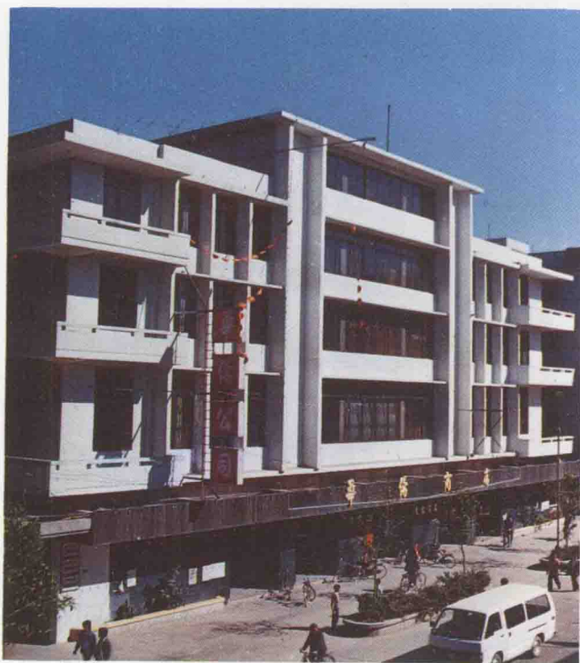
华侨公司及华侨商店，1978年建成营业，位于新平中路23号。
