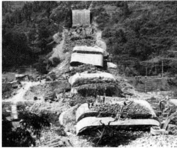
图 1—1—1 凤凰县大桥坍塌事故
