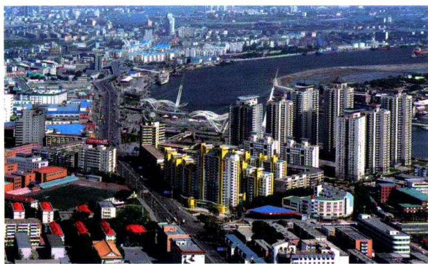
图 1-6 建筑物较多的城镇空间
