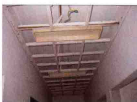
图1-2 木龙骨吊顶构造做法
