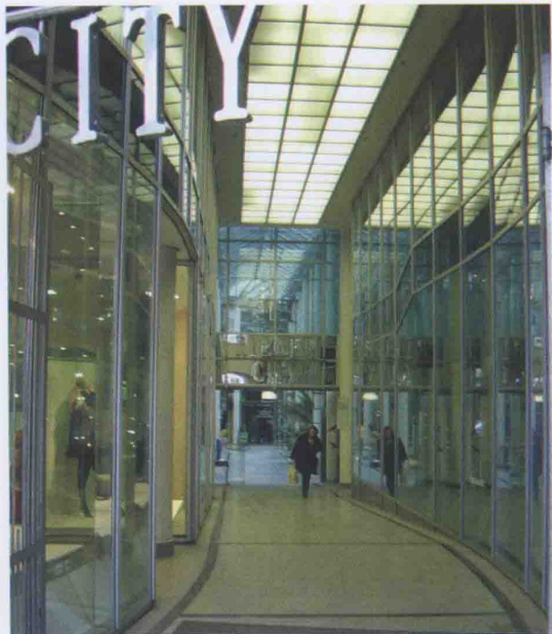
图 1-6 某商业建筑室外通道
