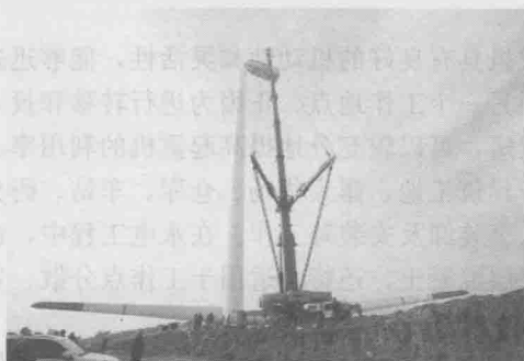
图 1-2 汽车吊施工作业例图
