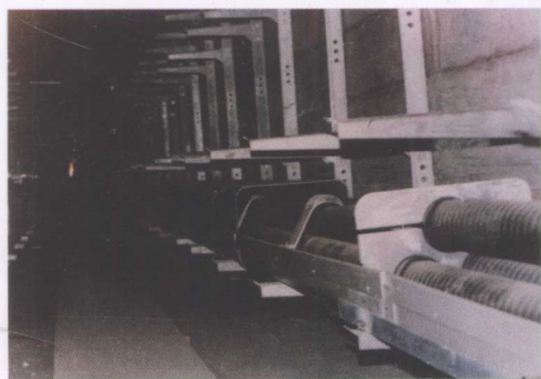
电缆用封闭式槽盒安装实况
