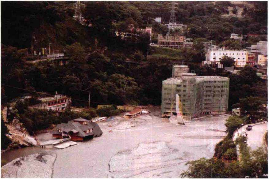
圖3-1a 土砂淹沒吊橋
