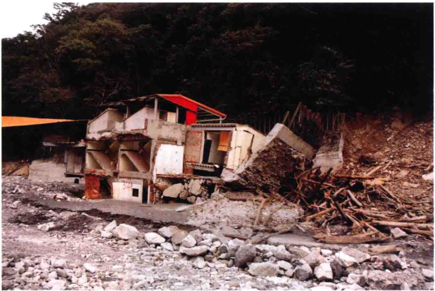
圖3-1b 土砂破壞河邊房舍和擋土牆
