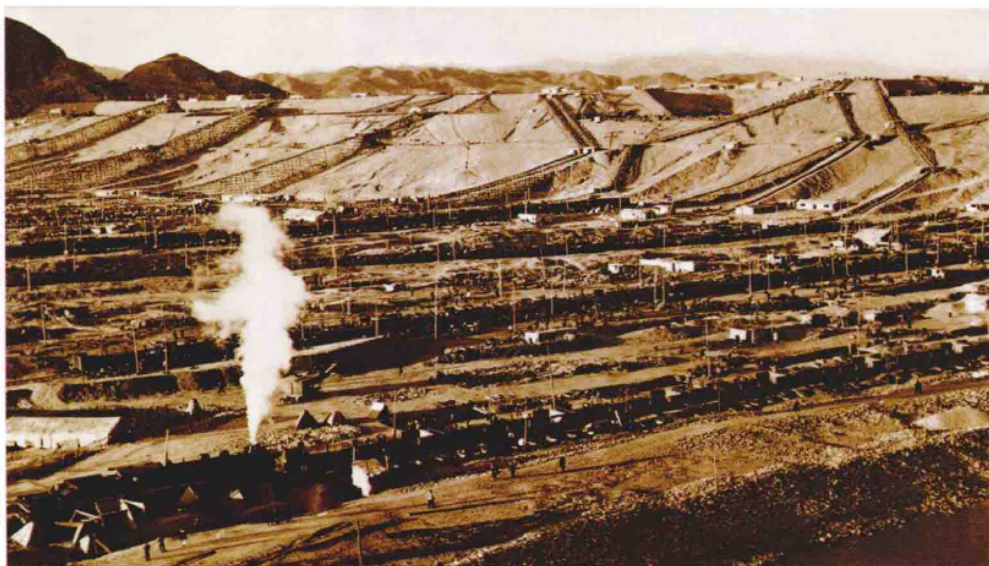
主坝建设工地
