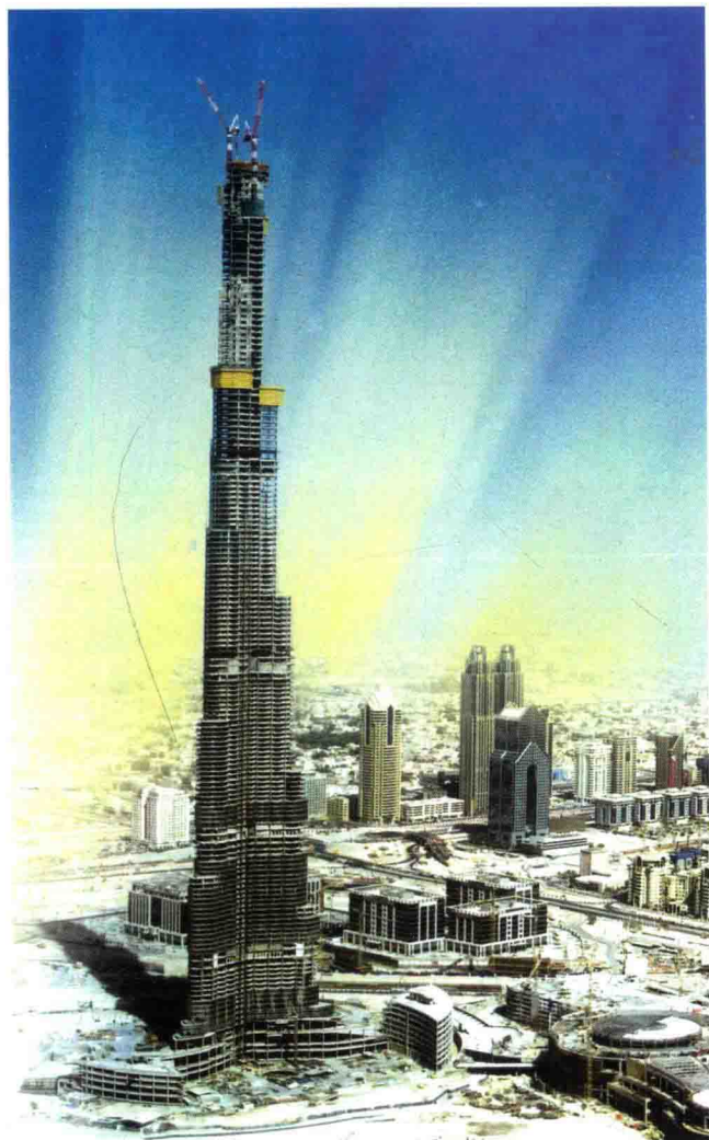
◀彩图1：迪拜哈利法塔大厦，高828 m，162层，2010年成为当时的世界最高摩天大楼。
