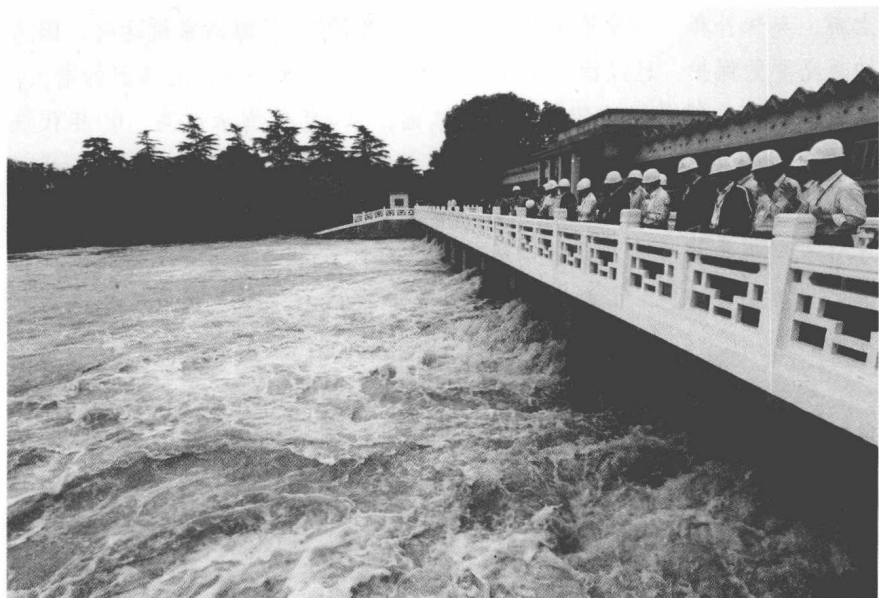
南水北调东线源头江苏江都泵站 缪宜江 摄
