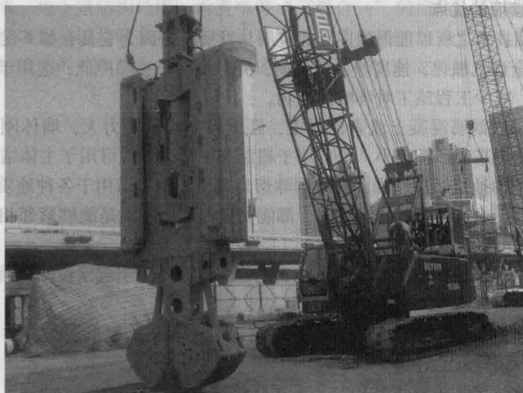
图 1-1 意大利地下连续墙抓斗
