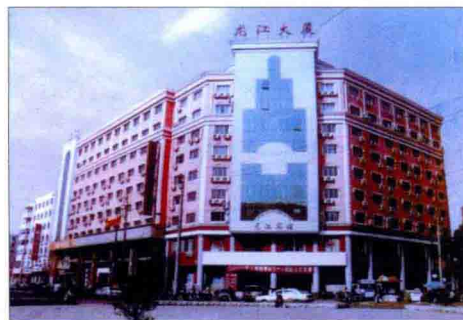
由局建设工程总公司承建的局综合楼
